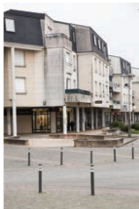
LogemLoiret - rue du Bourg
