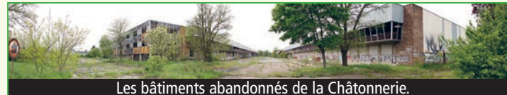
Les bâtiments abandonnés de la Châtonnerie.
