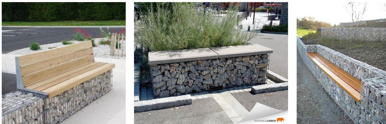
Figure 17 : Exemple de bancs en gabions
