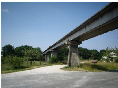
La voie d'essai de l'aérotrain d'Orléans est une ligne aérienne en béton sur pilotis situé entre Saran et Ruan dans le département du Loiret (région Centre). Le monorail fut emprunté par l'aérotrain lors des essais des prototypes I80-250 et I80-HV conçus par l'ingénieur Jean Bertin. C'est sur cette voie d'essai que le I80-HV établit le record mondial de vitesse d'un transport guidé avec 430,4 km/h le 5 mars 1974.
